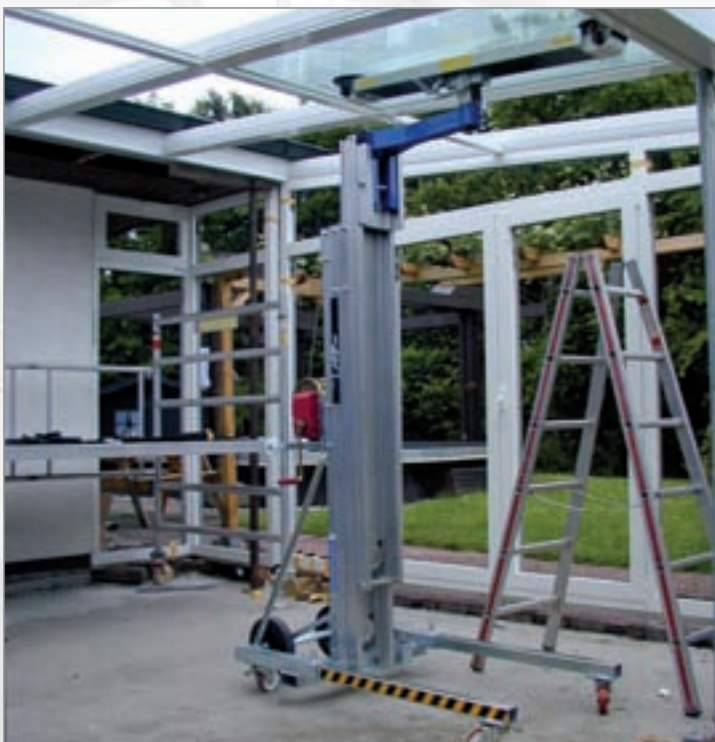
Vacuüm toestel voor het plaatsen van glas
